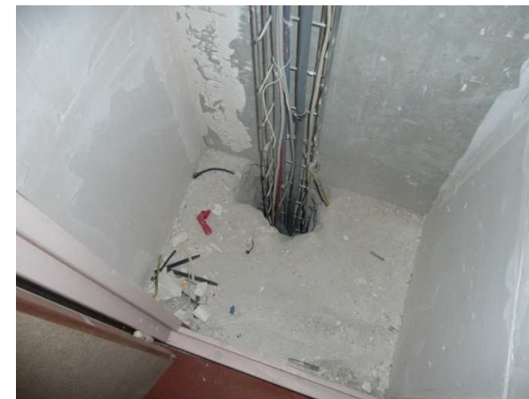
Recoupement gaine technique
