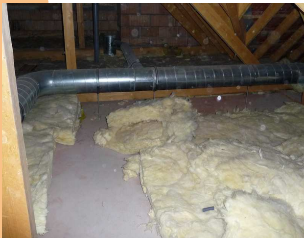
Absence d'isolant dans combles
