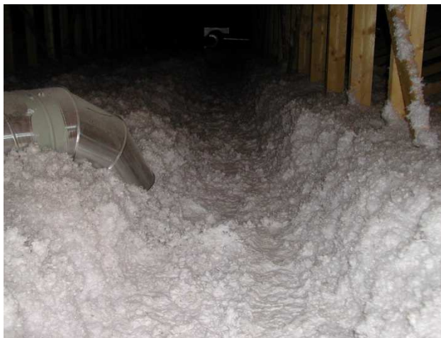
Absence d'isolant dans combles
