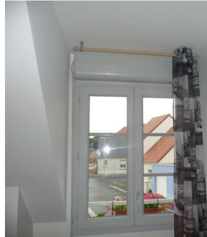
Absence d'entrée d'air dans pièce principale
