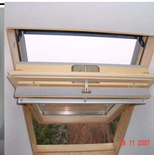
Absence d'entrée d'air dans pièce principale
