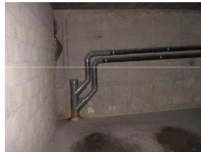
Protection des conduits et gaines
