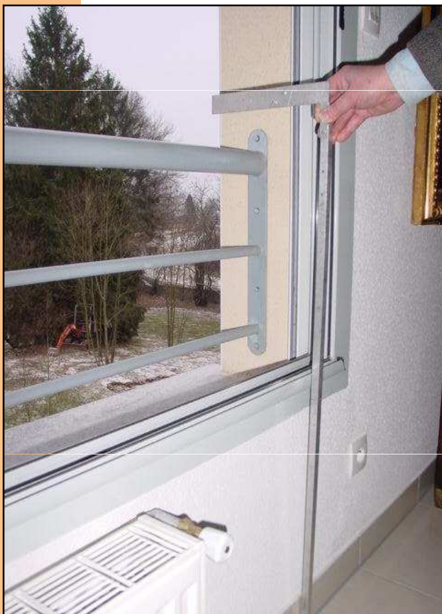
Fenêtre avec barre d'appui < 1 m de hauteur
